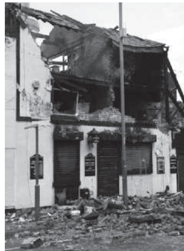
▲ figuur 9 de gevolgen van een supersnelle (explosieve) verbranding van aardgas
